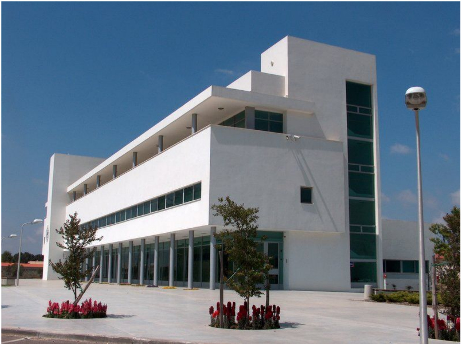
בניין מועצה אזורית מנשה, וינשטין-ועדיה אדריכלים, 2005. הצללת חזיתות המתייחסת לאקלים, תוך פרשנות עכשווית לסגנון הבינלאומי
