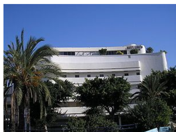
קולנוע אסתר שבכיכר צינה דיזנגוף. אדריכל יהודה מגידוביץ', 1938
